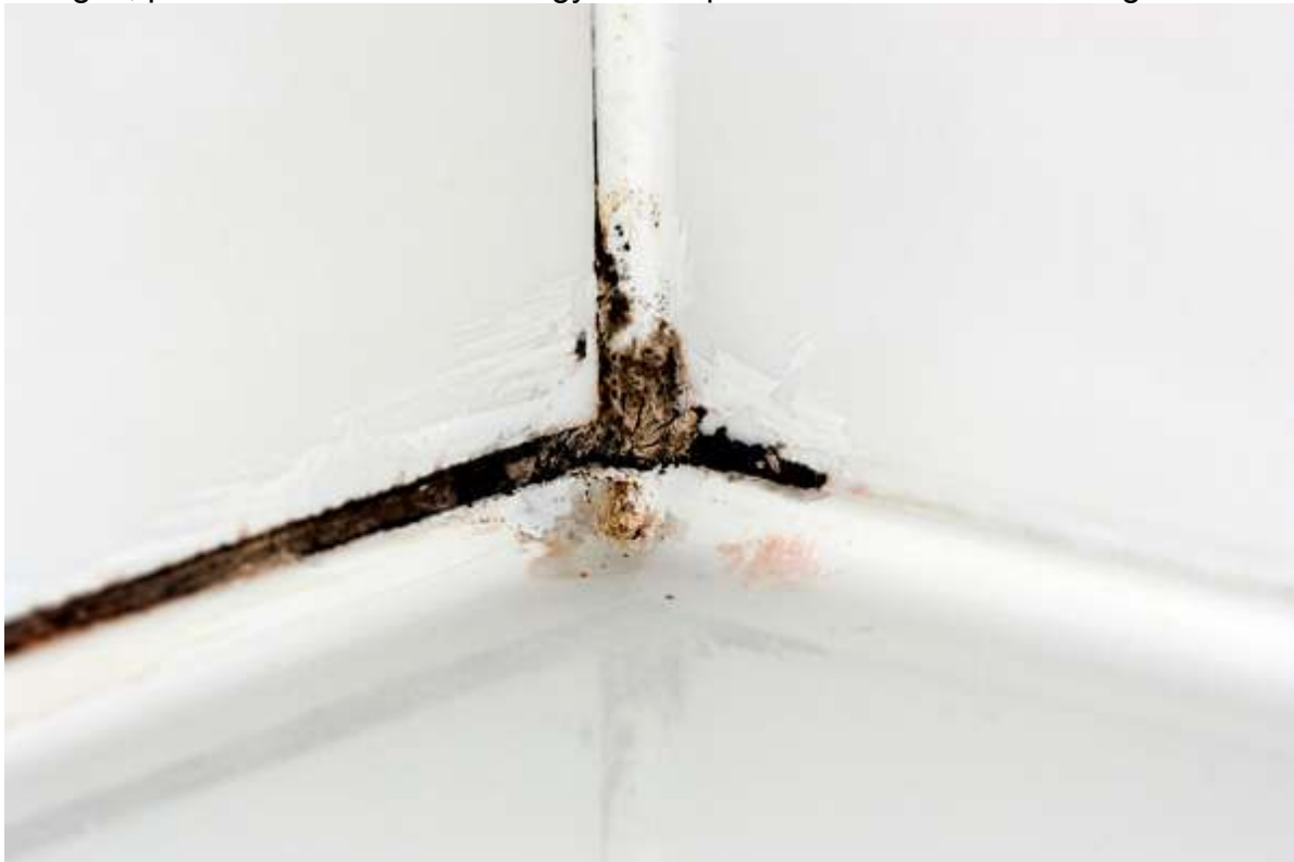
65.sz. ábra ZUHANYOZÓ GOMBÁSODÁSA
